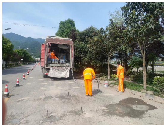
图 1-3 注浆施工
