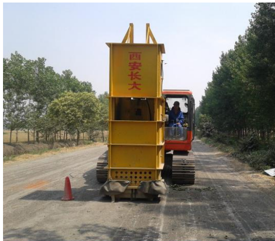
图 2-3 微裂施工
