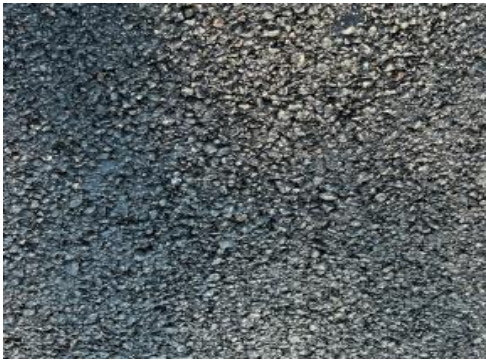
图 13 试验路现场热再生路面碾压后效果
