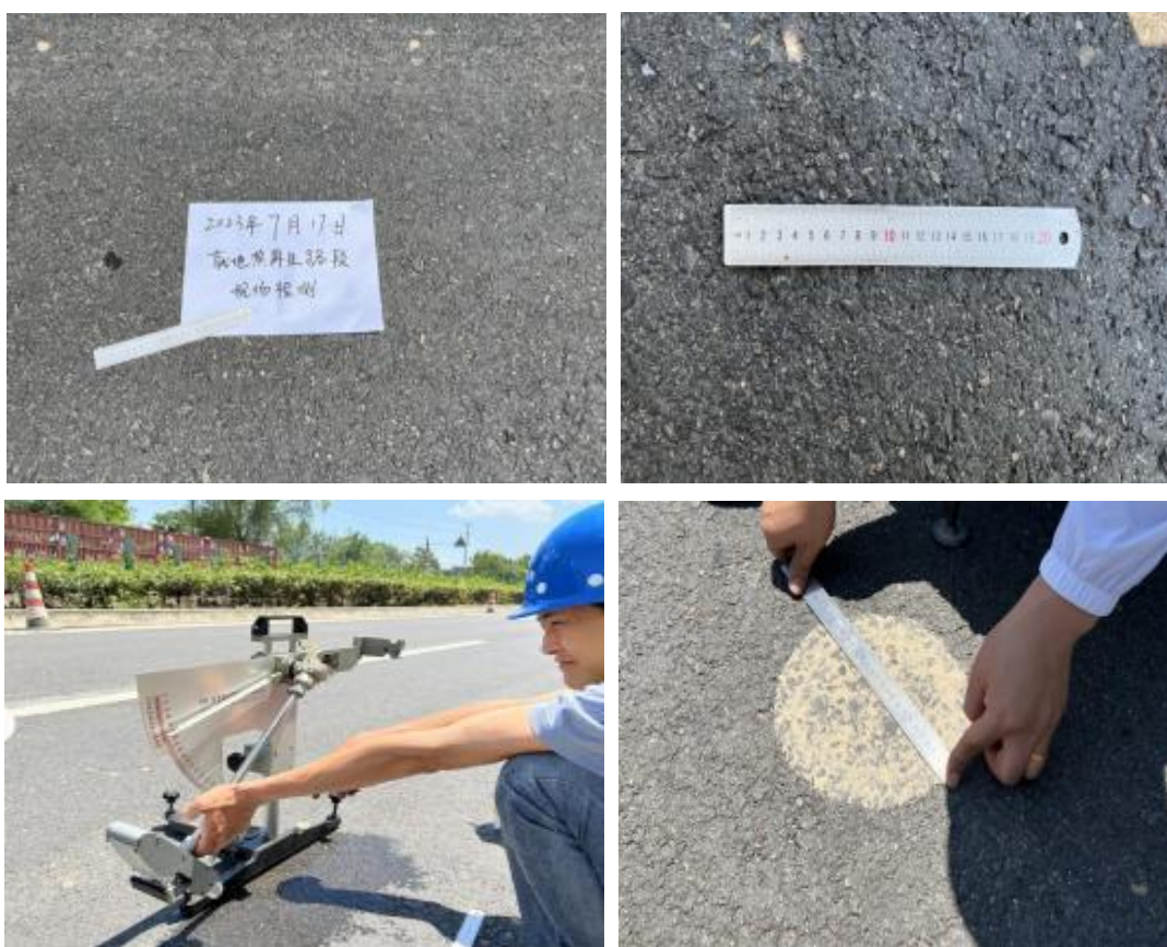
图 17 2023 年 7 月热再生路面表面及现场检测
