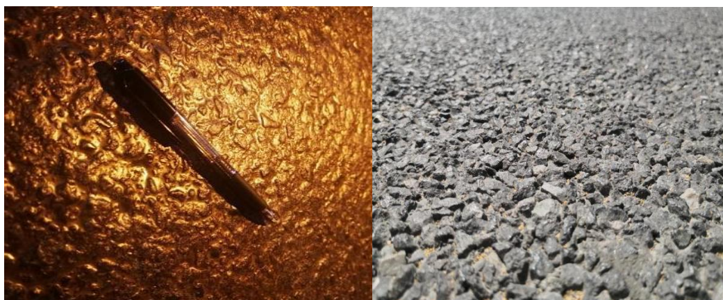
图 1 隧道沥青路面普遍受污
