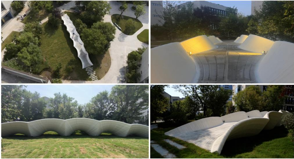
图 1-5 空间双曲 3D 打印桥
