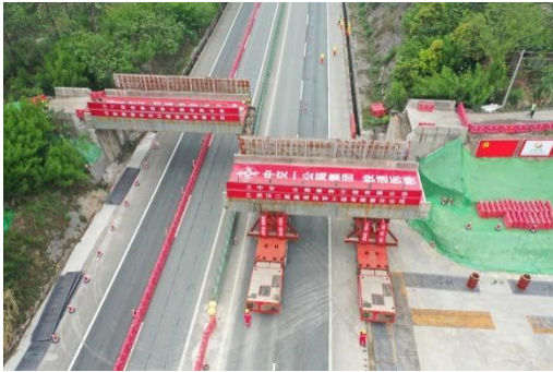
(a)开阳高速上跨天桥拆除
